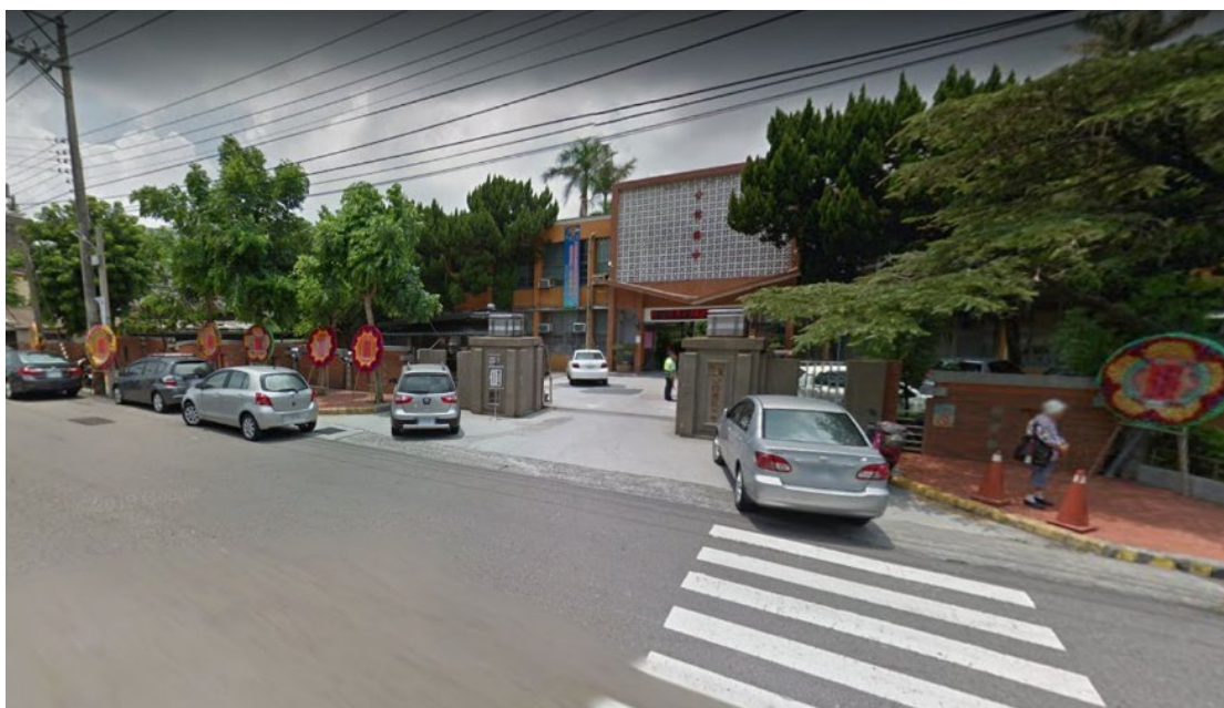
▲人行道開口有高差，且開口有車輛停放。(公館國中) 74
