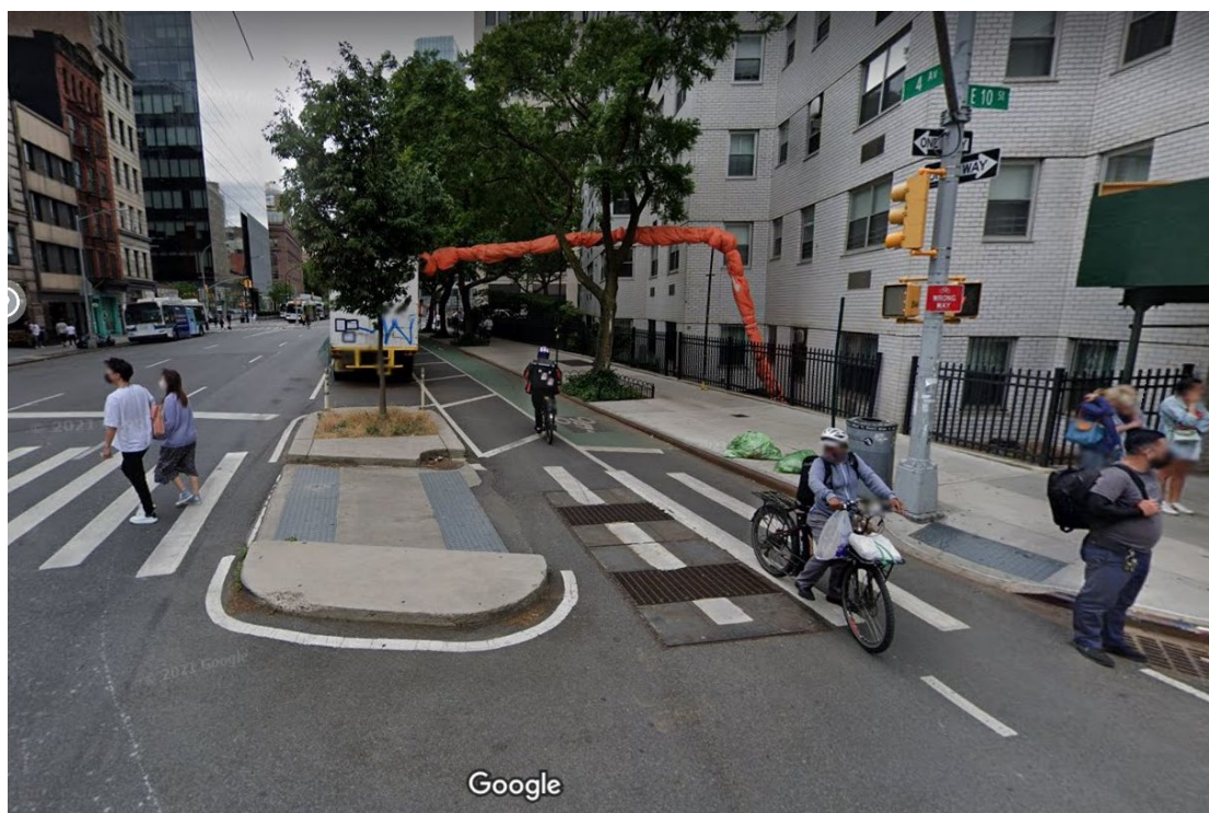
▲位於紐約，運用槽化標線及庇護島分隔的慢車道。 70
